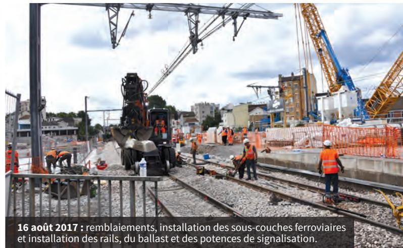
**16 août 2017** : remblaiements, installation des sous-couches ferroviaires et installation des rails, du ballast et des potences de signalisation.
