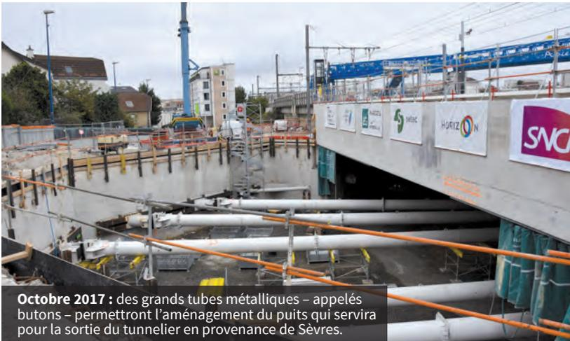
**Octobre 2017** : des grands tubes métalliques – appelés butons – permettront l'aménagement du puits qui servira pour la sortie du tunnelier en provenance de Sèvres.
