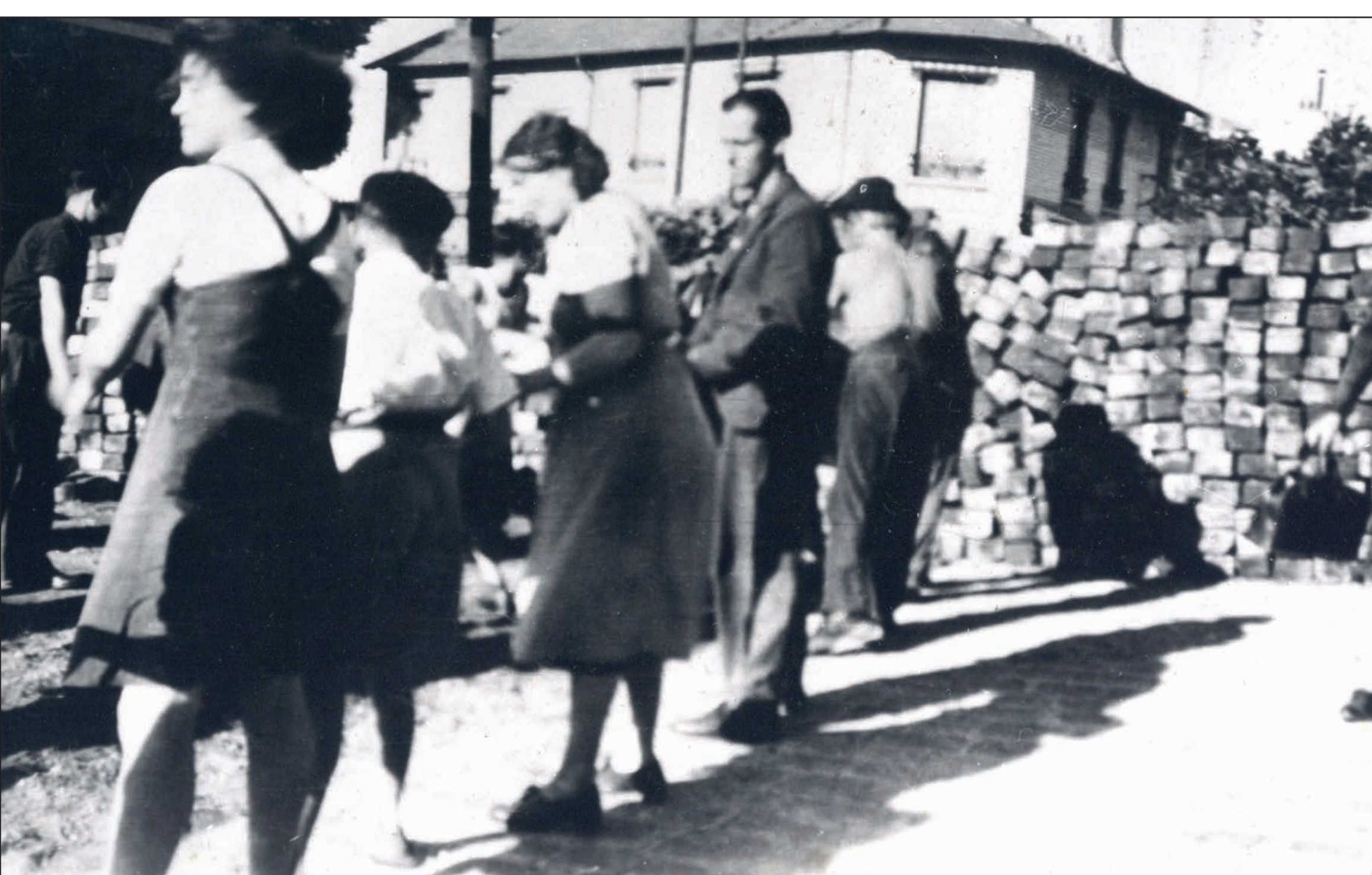
Les barricades sont démolies. © Archives municipales
