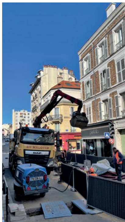
Pendant ce temps, Enedis a effectué des travaux sur le réseau électrique de la rue Paul Vaillant-Couturier
