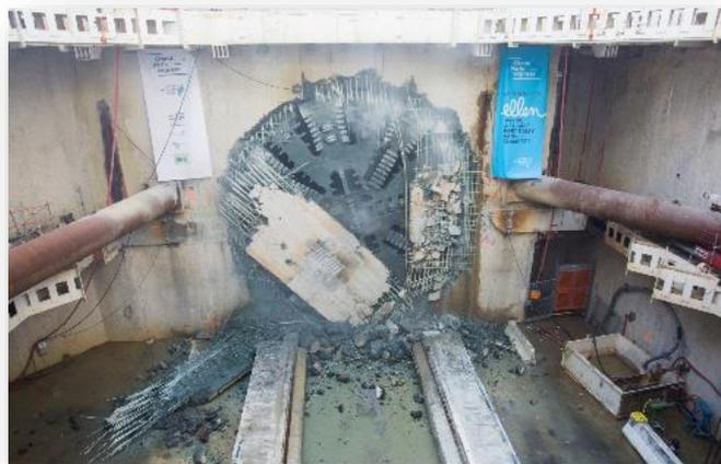
A 26 mètres de profondeur, le 28 juillet le tunnelier perce la cloison de la boîte de la gare
