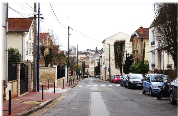
La rue d'Estienne d'Orves avant travaux
