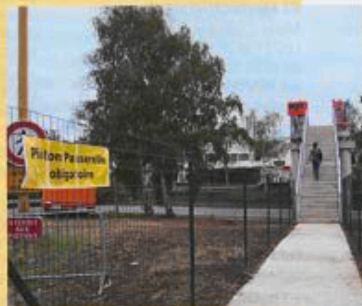
Les travaux de la passerelle définitive du Petit Clamart débutent en avril.
