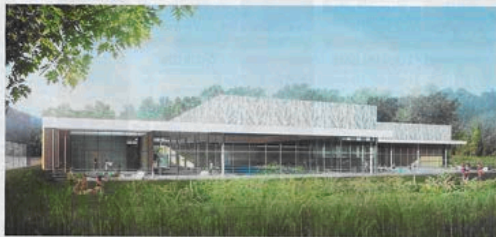
Les travaux de la nouvelle piscine du Jardin Parisien débutent en avril.
