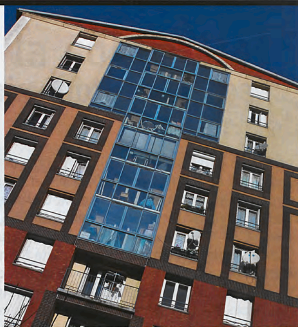
Le projet de Loi de finances 2011 met en péril la construction de logement neufs, et l'entretien du parc de logements existants, comme ici à la Cité de La Plaine.
