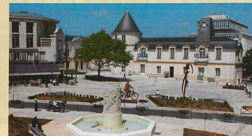
La place de la mairie rénovée : 3 200 m 2 pour flâner, se rencontrer, échanger.
