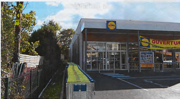
Le nouveau supermarché Lidl accueille les Clamartois au 99-103, rue de la Porte de Trivaux.
