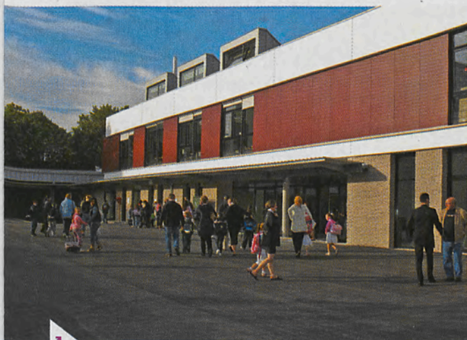
Les travaux d'extension du préau du nouveau bâtiment de l'école Senghor ont débuté cet été et se termineront aux vacances de la Toussaint.
