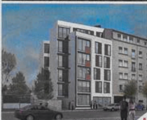
Vue depuis l'avenue Jean Jaurès
