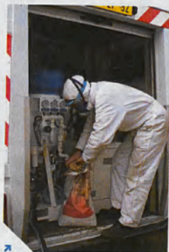
Préparation de la machine avant "hydrogommage"
