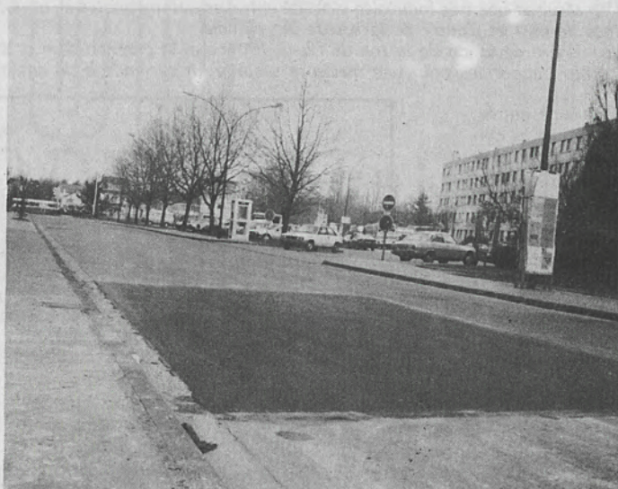
Une zone très dégradée vient d'être refaite à l'extrémité sud de l'avenue de la Porte-de-Trivaux
