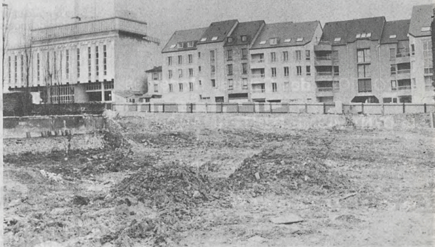
— le verso des bâtiments en rénovation de la rue piétonne Jean-Jaurès
