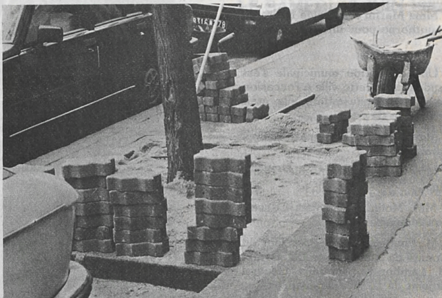
Une solution qui contribue à améliorer la propreté de notre ville : l'installation de pavés autobloquants autour des arbres
