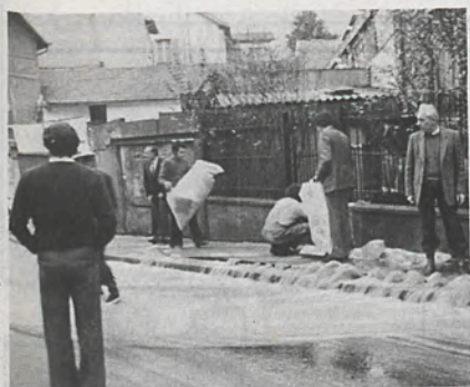
Rue Jean-Baptiste-Clément, suite à l'éclatement d'une canalisation d'eau de grand débit, le bitume du trottoir est soulevé par la forte pression de l'eau.
