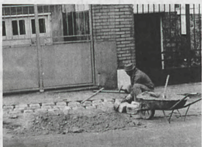
Après la pose de nouveaux câbles, le pavage est réalisé devant les entrées de garages.
