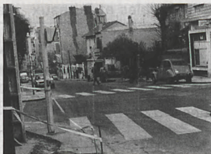
Rue Lazare-Carnot, les P. et T. posent de nouvelles lignes téléphoniques.
