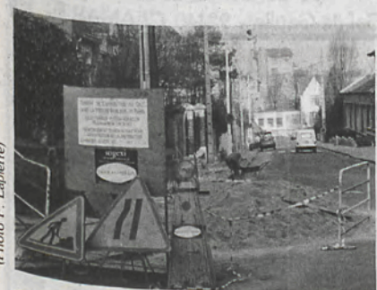
Changement des canalisations de gaz dans la rue Gathelot.
