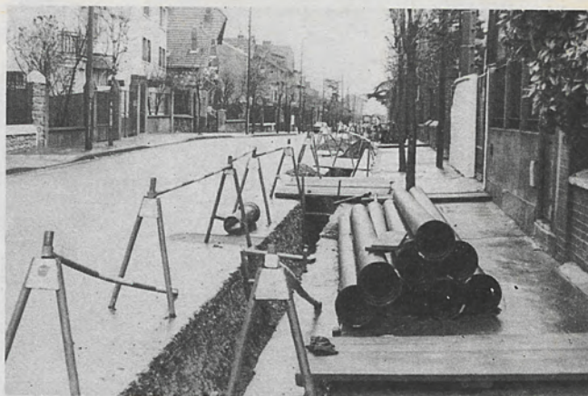
Avenue Marguerite Renaudin, Rue Hébert, Boulevard des Frères Vigoureux changement des canalisations du gaz. (Photo : Pascal Ruby C.P.C.C.)
