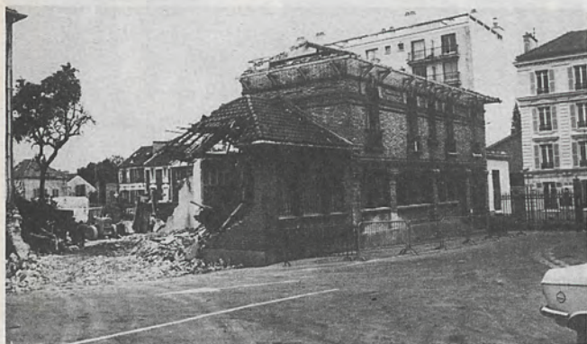
1977 - Début des Travaux
