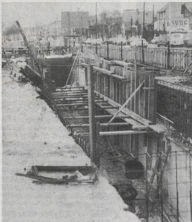
Une nécessité pour assurer la sécurité des piétons qui traversent l'avenue du Gal-de-Gaulle au niveau de l'hôpital Bécléré : un passage souterrain (Photo F. Lapière, C.P.C.C.)
