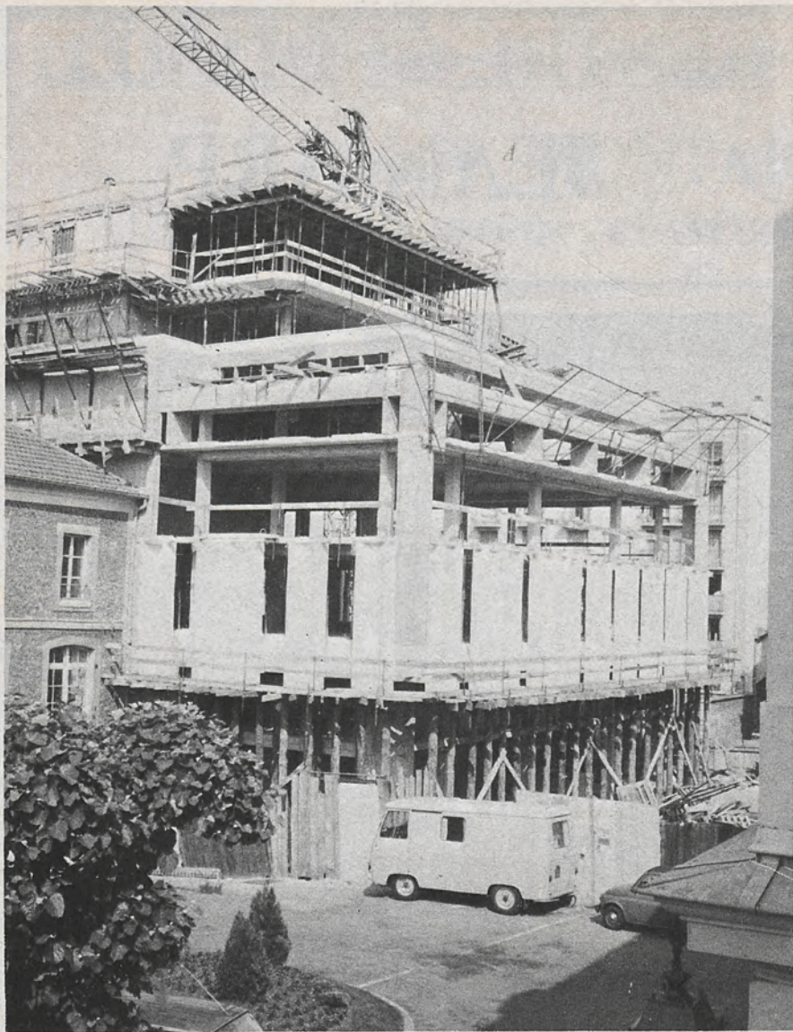
Un chantier impressionnant : le nouveau centre administratif
