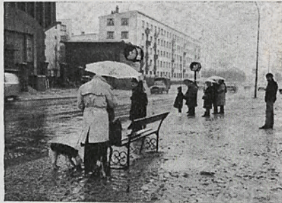
Arrêt « Pavé Blanc » : AVANT
