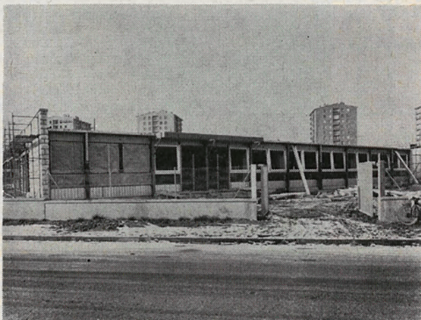
Le groupe scolaire « Pasteur » en construction
