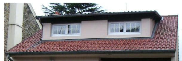
Lucarne rampante à ouverture multiple : disposition interdite
