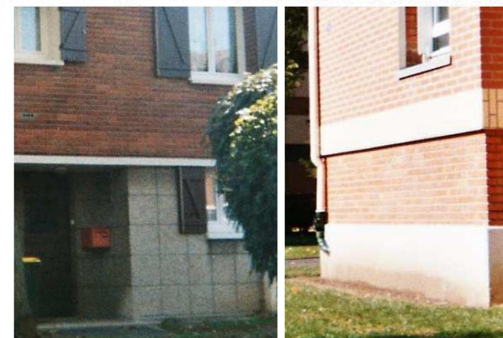
Traitement différencié des façades : à droite, le corps de façade est séparé du soubassement par un bandeau en brique blanche
