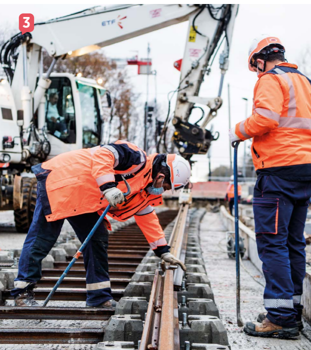
3 Les ouvriers alignent les coupons de rail ensemble.
