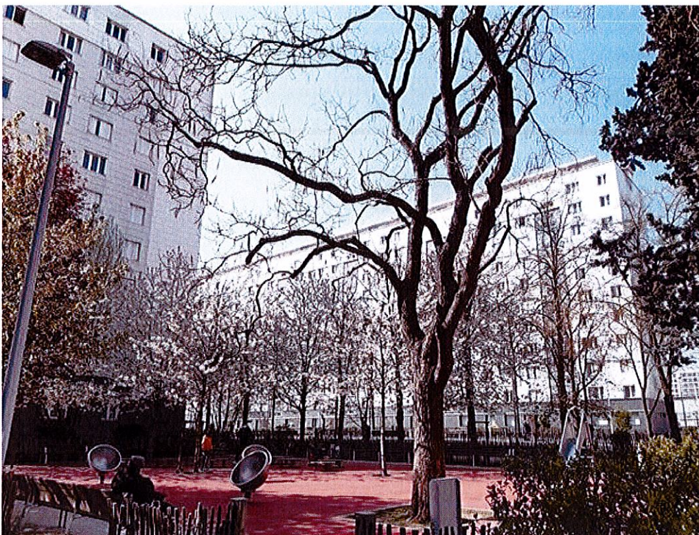
Clamart, le 16 avril. La cité des 3F, qui comptait 665 logements sociaux, va être presque en totalité démolie. LP/Marjorie Lenhardt
