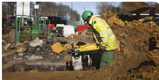
Après la pose de fourreaux électriques, un ouvrier compacte la terre en rebouchant la tranchée, afin de stabiliser le sol. Les câbles électriques seront ensuite déroulés à l'intérieur de ces fourreaux.
