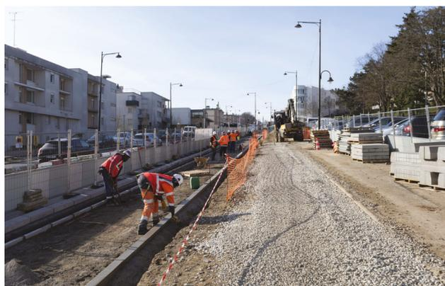
4 Remise en état de la chaussée après intervention : les réseaux sont recouverts d'une nouvelle couche de roulement (goudron ou bitume) pour laisser place aux travaux du Tram 10.
