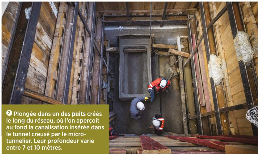
2 Plongée dans un des puits créés le long du réseau, où l'on aperçoit au fond la canalisation insérée dans le tunnel creusé par le micro-tunnelier. Leur profondeur varie entre 7 et 10 mètres.
